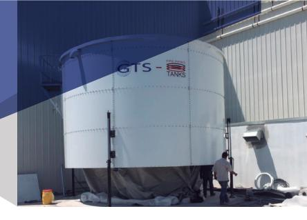
Los ascensores hidráulicos son utilizados para elevar el tanque de almacenamiento de agua anillo por anillo hasta 12 mts de altura y están compuestos por una central hidráulica, cilindro y piston.
